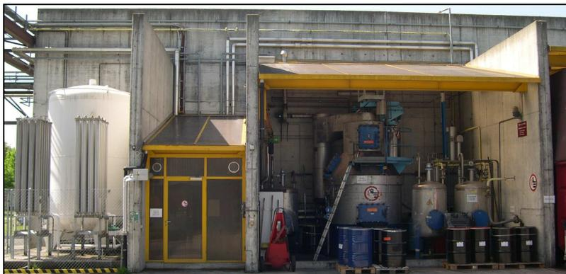
Photo : Reserve d'azote, local de commande et distilleuse (avec cuves tampons)
